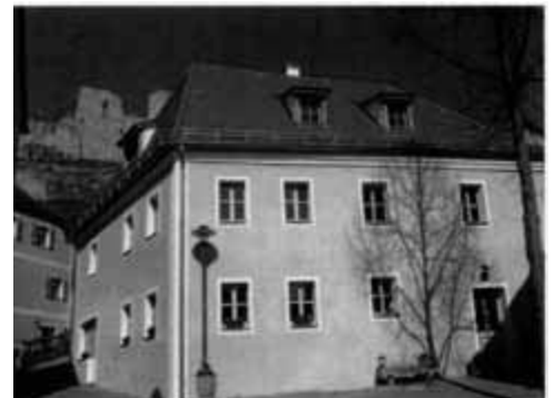
nach der Sanierung Foto: Landratsamt Regensburg
