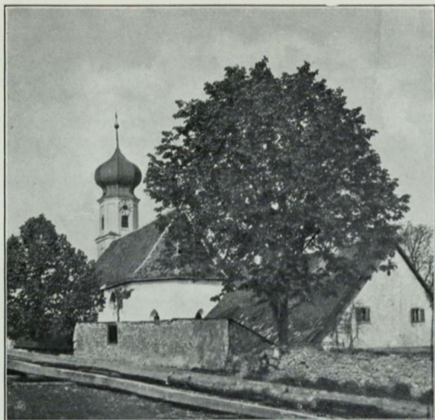
Frauenberg Ostansicht der Pfarrkirche (1905)
